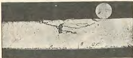
Fig. 171. Brudt Jærnbetonbjælke, Bruddet skyldes Betonens Knusning 1) .
